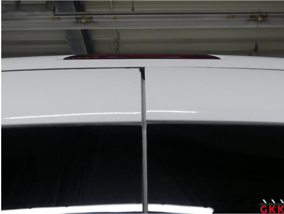
Bild 29 Hecktür rechts, Spaltmaß fehlerhaft, instand setzen
