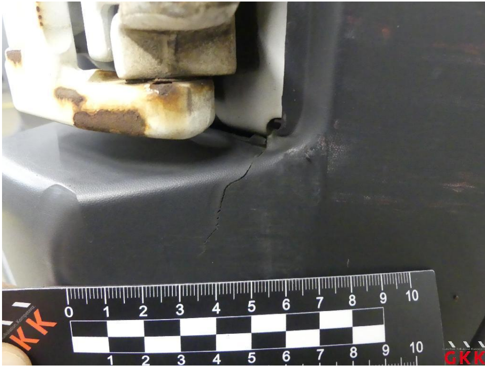
Bild 27 Stoßfänger hinten, Ecke rechts -unlackiert-, gerissen, ersetzen
