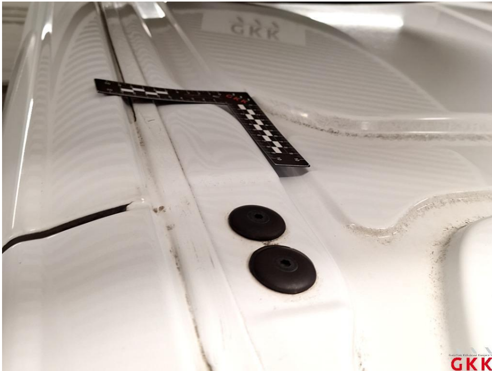
Bild 23 Dach, beschädigt, kalt drücken
