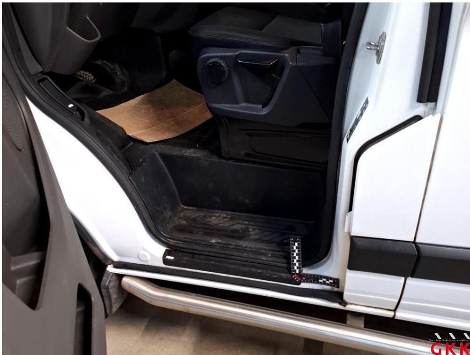
Bild 16 Tür vorne links, Dichtung, lose, ersetzen
