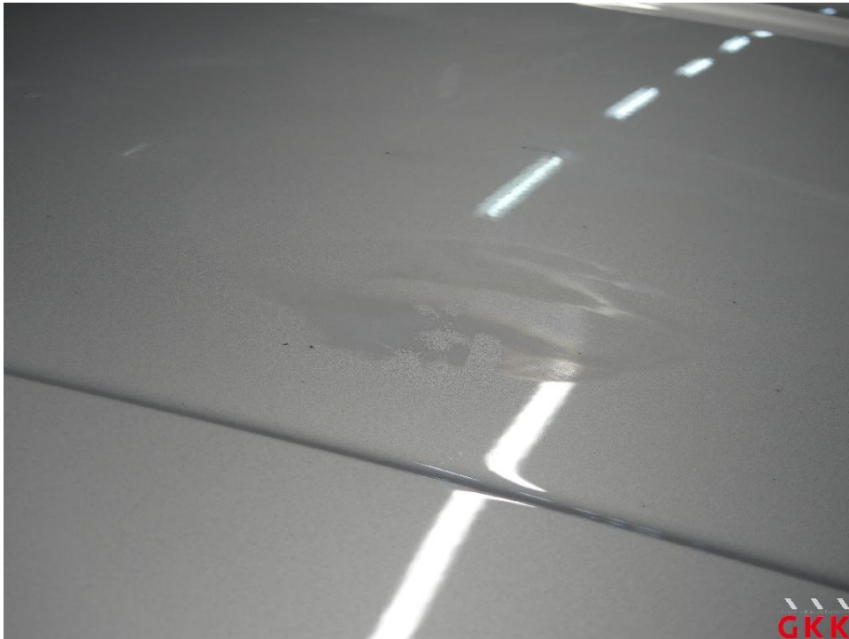
Bild 21 Dach, verschmutzt, aufbereiten
