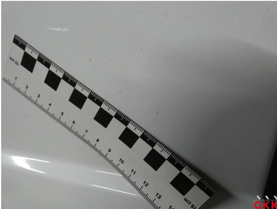
Bild 29 Hecktür links, korrodiert, lackieren
