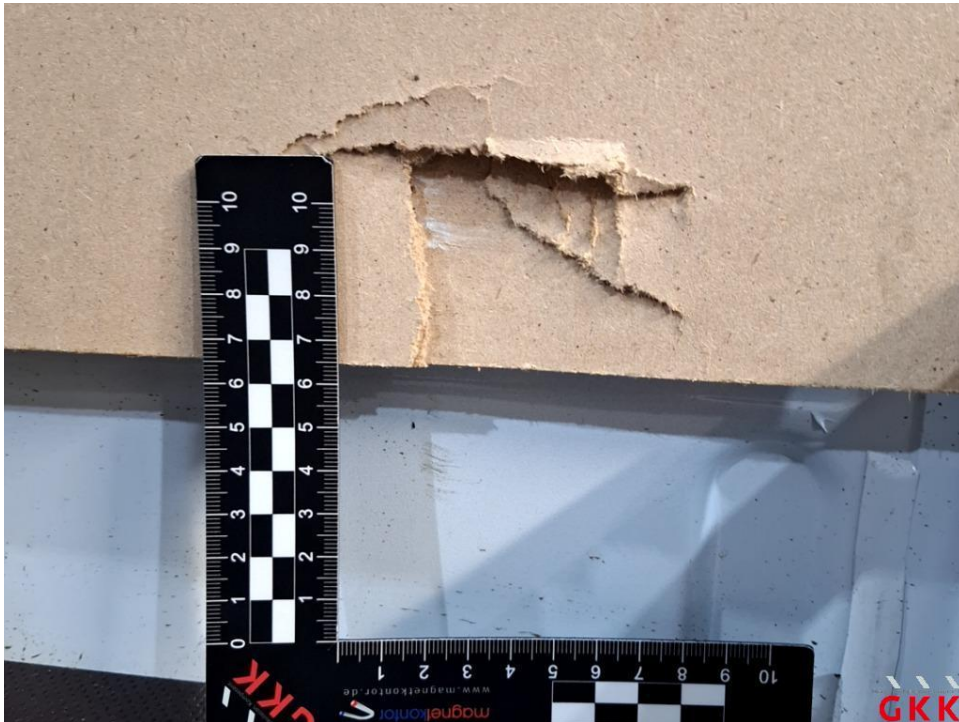
Bild 29 Seitenwand rechts, Innenverkleidung, beschädigt, ersetzen
