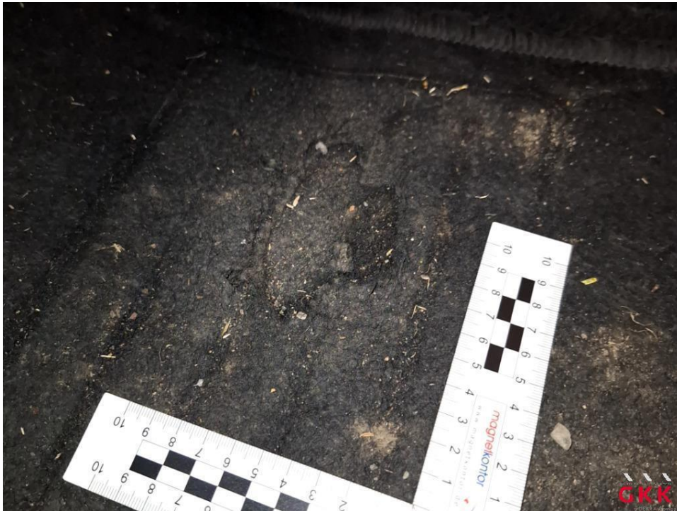
Bild 33 Fußmatte(n), vorne links, beschädigt, ersetzen
