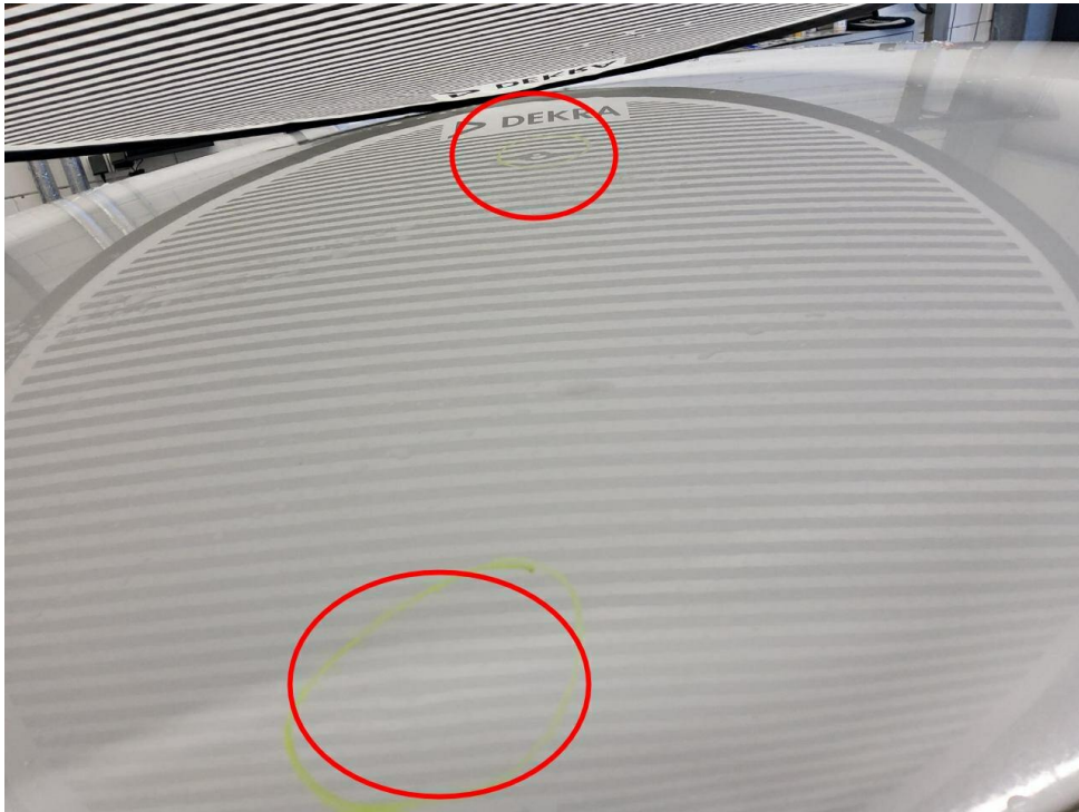
Bild 15 : Dach, mehrfach eingedellt, drücken
