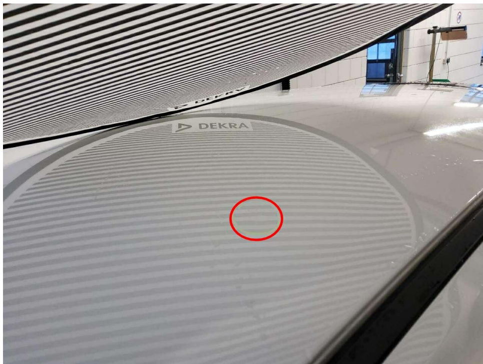
Bild 14 : Dach, mehrfach eingedellt, drücken
