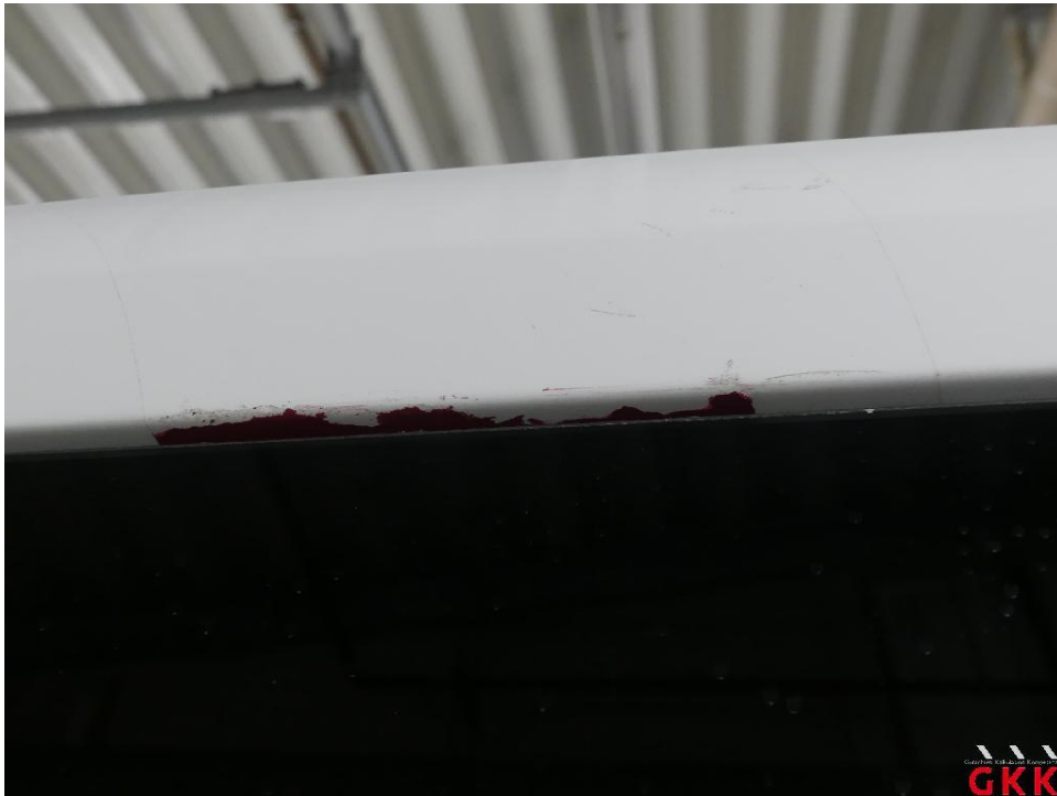
Bild 23 Seitenwand rechts, Klebreste, entfernen
