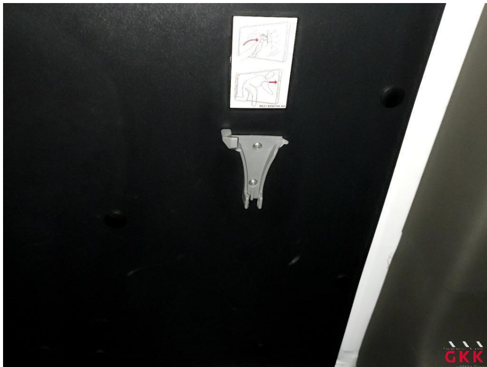
Bild 14 Nothammer fehlt und Halter beschädigt, ersetzen
