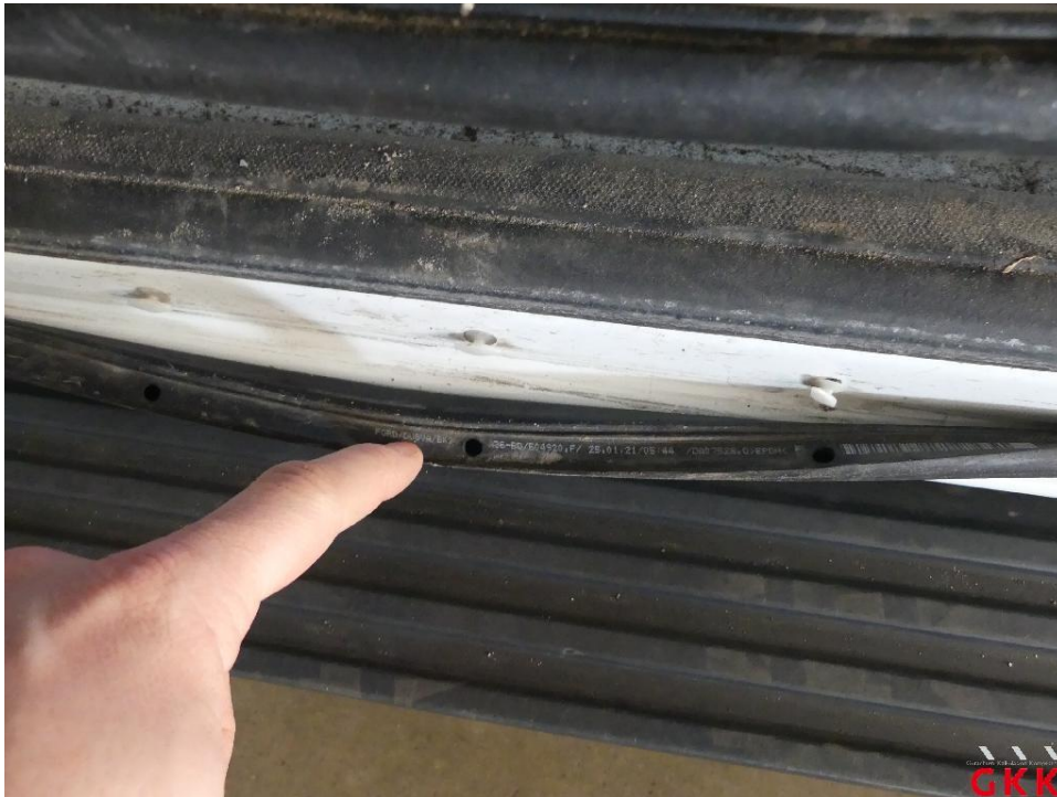
Bild 17 Schiebetür rechts, Dichtung -Einstieg-, lose, ersetzen
