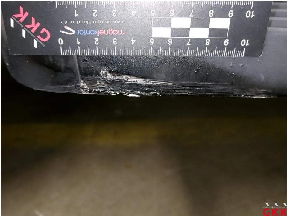
Bild 32 Trittbrett rechts verkratzt, ersetzen
