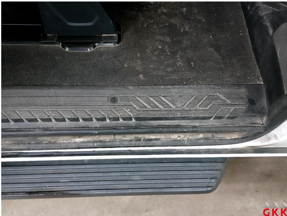
Bild 20 Schiebetür rechts, Dichtung -Einstieg-, beschädigt, ersetzen
