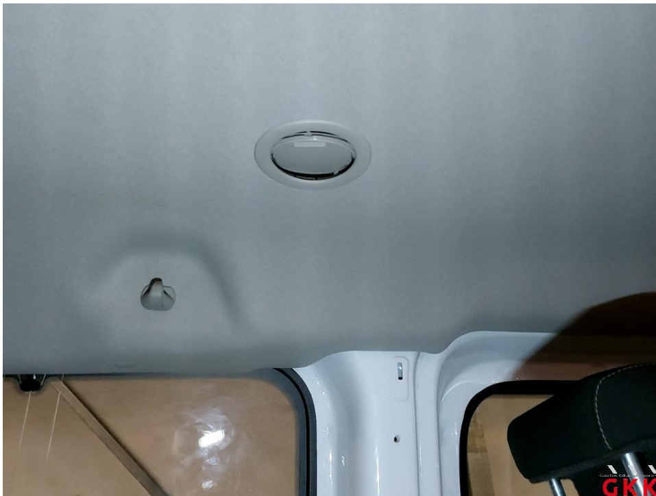
Bild 18 Himmel Luftdüse hinten, beschädigt, ersetzen
