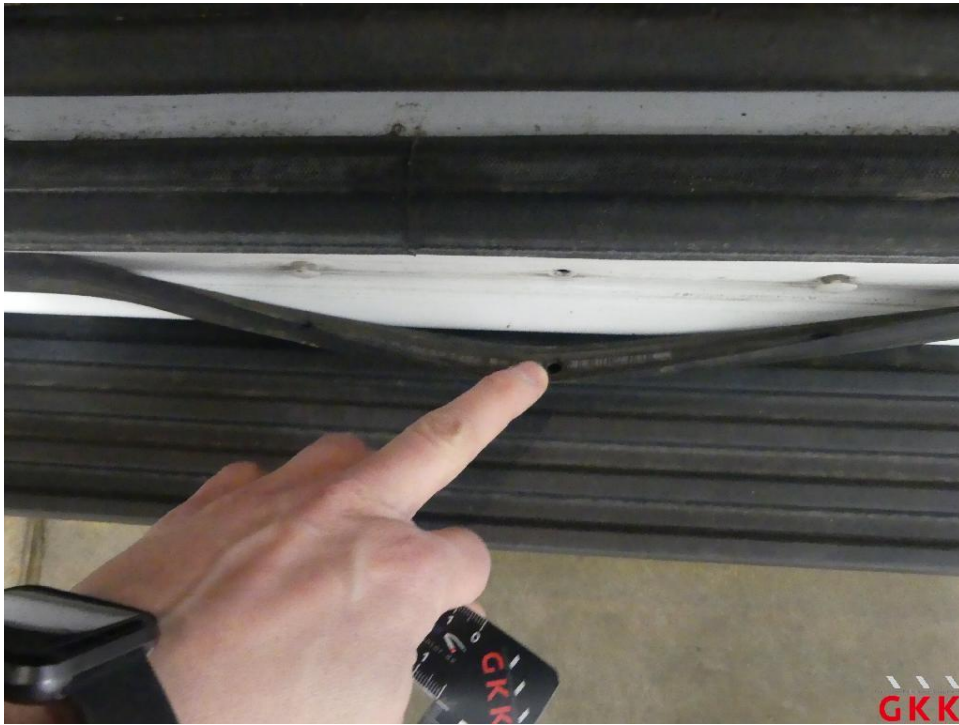
Bild 15 Schiebetür rechts, Dichtung -Einstieg-, lose, ersetzen
