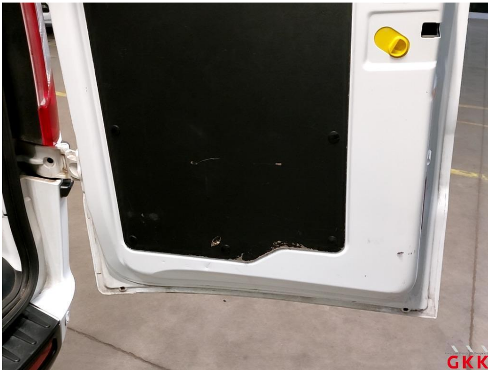
Bild 34 Hecktür rechts, Innenverkleidung, beschädigt, ersetzen
