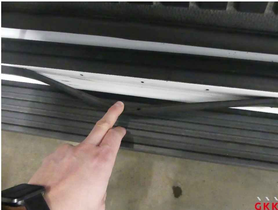
Bild 24 Schiebetür rechts, Dichtung -Einstieg-, lose, ersetzen
