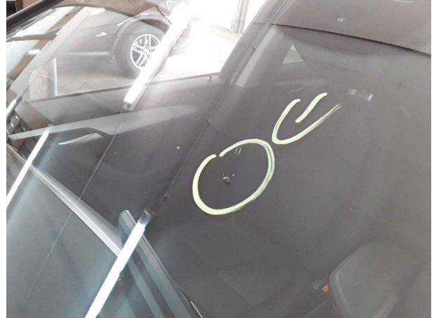
Beschädigung #3: Verglasung: Frontscheibe (Rissbildung) - Steinschlag - erneuern
