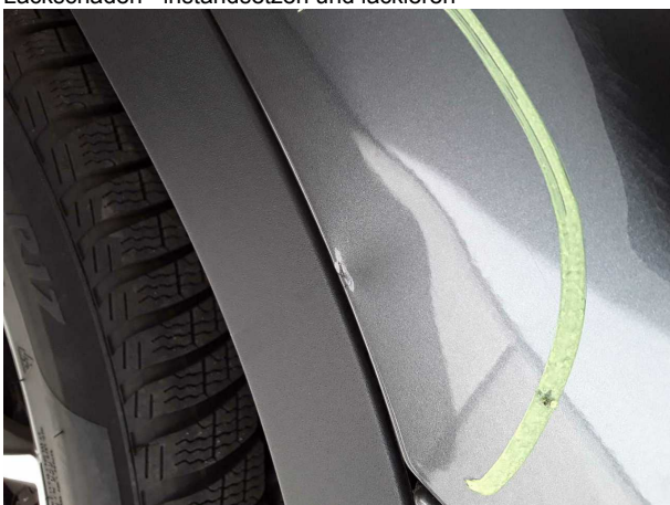
Beschädigung #4: Seitenwand links: Seitenwand - Delle / Lackschaden - instandsetzen und lackieren
