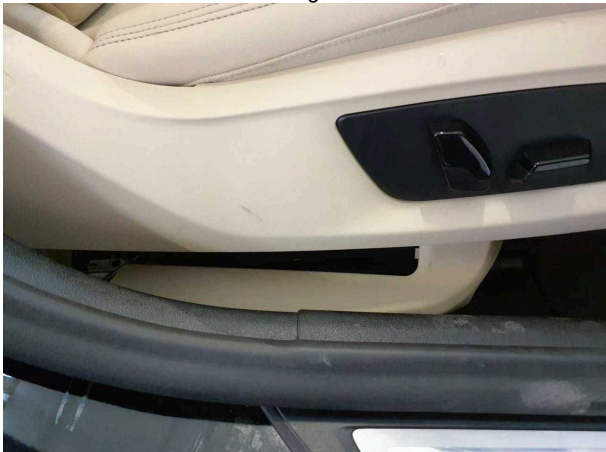
Beschädigung #3: Verkleidungen/Abdeckungen: Verkleidungen/Abdeckungen (Sitz vorne rechts unten) - lose - erneuern
