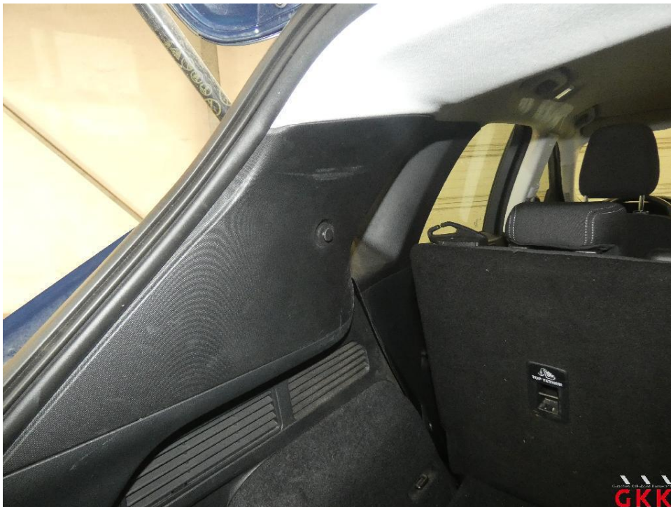
Bild 18 Laderaum, Abdeckung, fehlt, ersetzen
