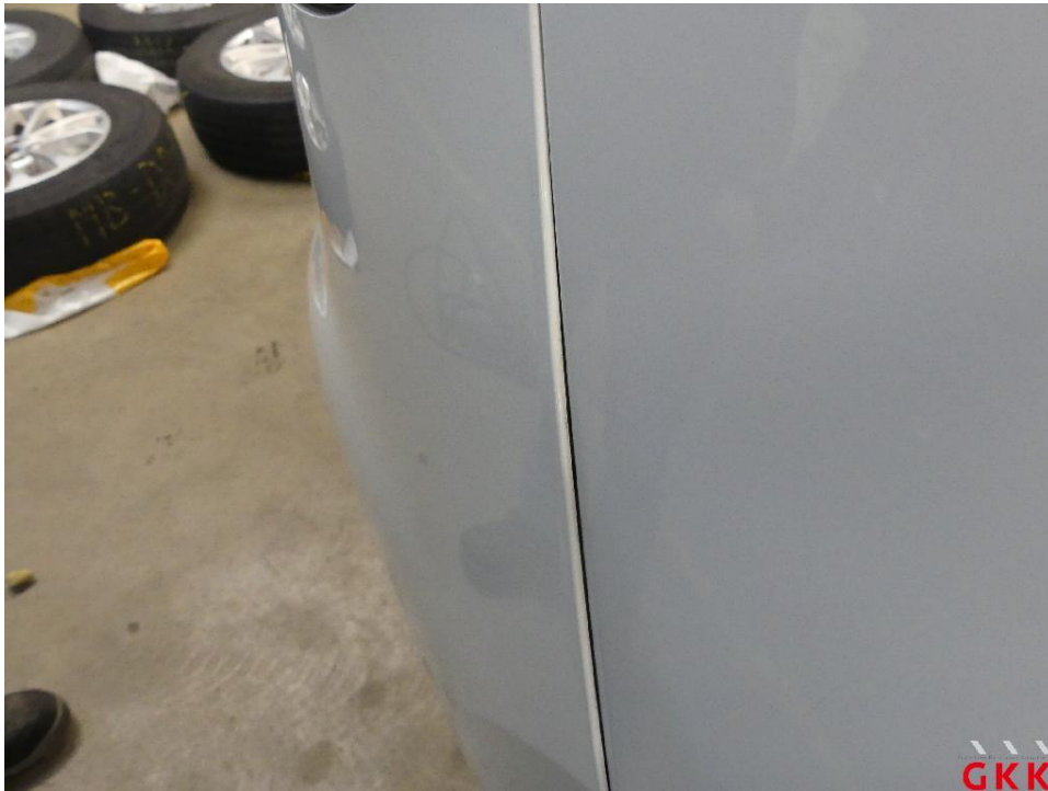
Bild 21 Stoßfänger hinten, Verkleidung -lackiert-, lose, instand setzen
