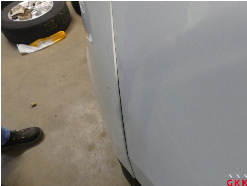
Bild 22 Stoßfänger hinten, Verkleidung -lackiert-, lose, instand setzen
