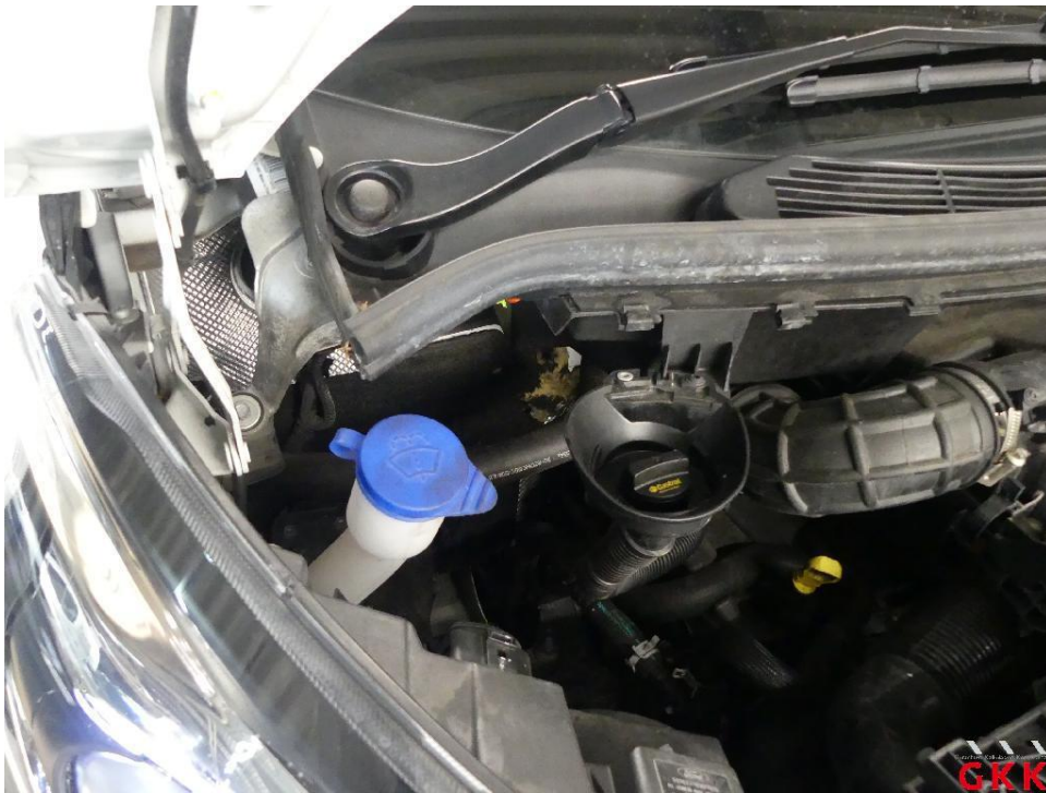
Bild 16 Motorraum, Dämmmatte, beschädigt, ersetzen
