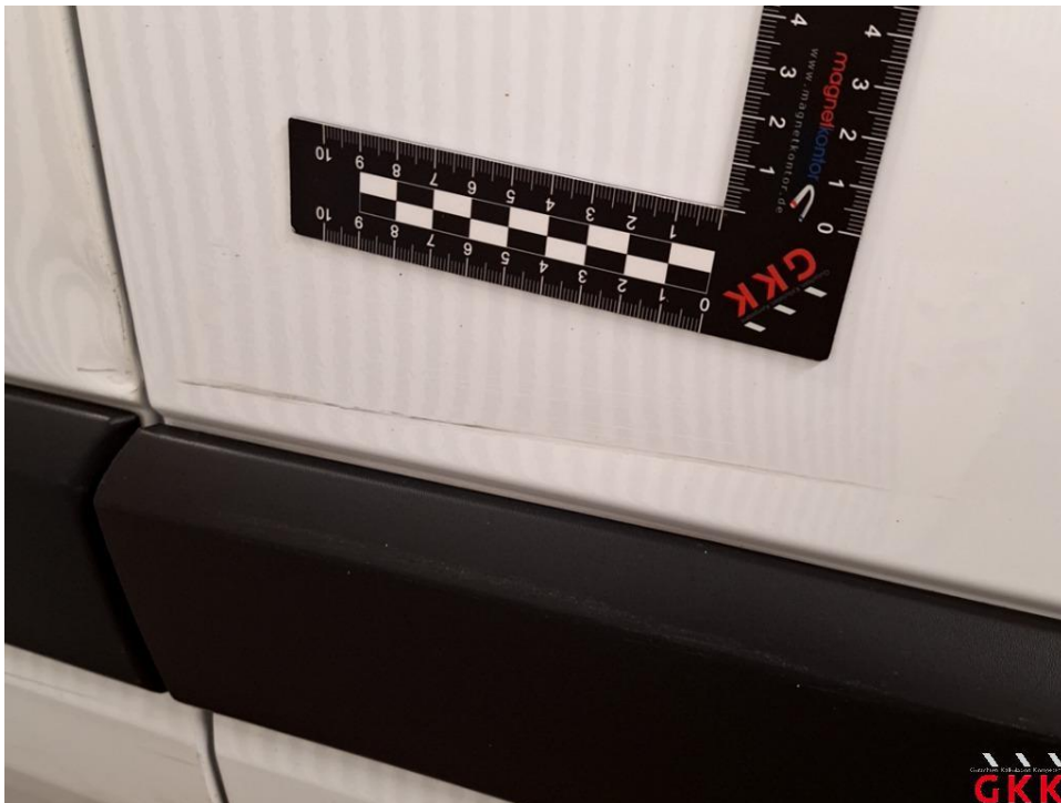
Bild 32 Tür vorne links, beschädigt, instand setzen - lackieren
