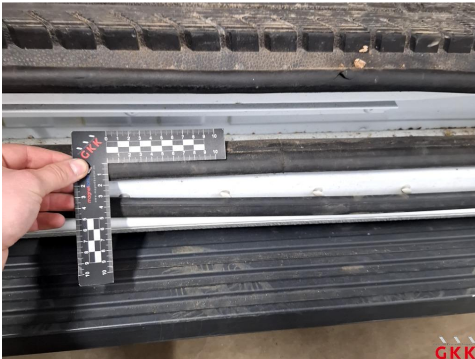
Bild 40 Schiebetür rechts, Dichtung -Einstieg-, beschädigt, ersetzen
