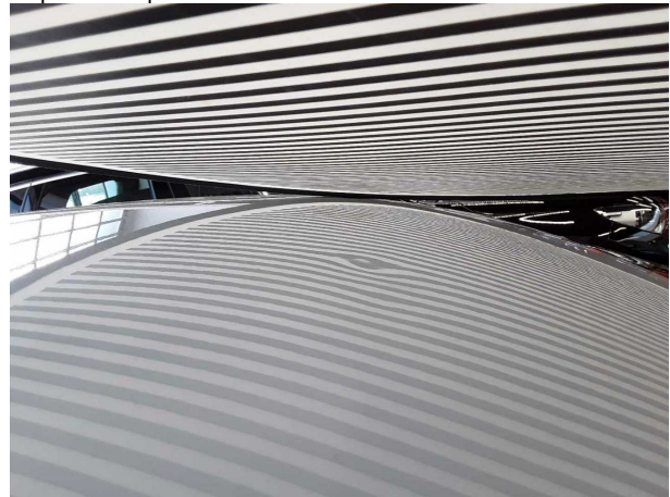
Domage #11: Toit: Toit - bosse(s) - Réparer et repeindre
