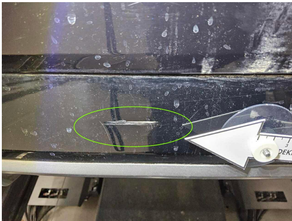
Bild 35 : Stoßfänger hinten unterhalb verkratzt und deformiert
