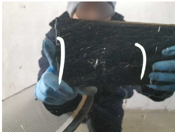
Domage #7: Porte ArD: Porte - Bosse, dommage peinture - Réparer et repeindre
