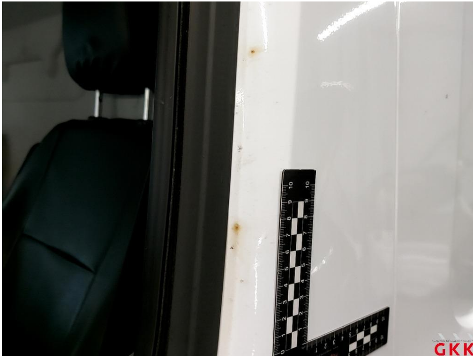
Bild 19 Tür vorne links, korrodiert, instand setzen - lackieren
