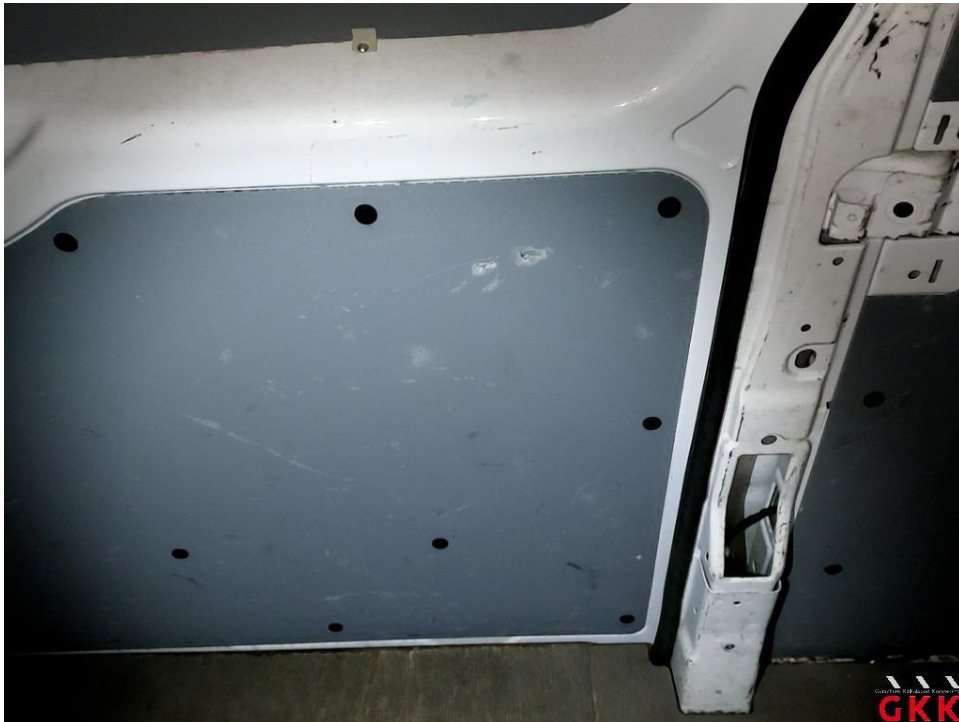
Bild 33 Schiebetür rechts, Innenverkleidung, beschädigt, ersetzen
