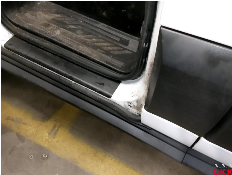
Bild 42 Tür vorne links, Dichtung -Einstieg-, lose, ersetzen
