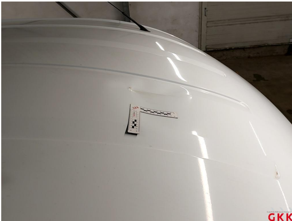
Bild 18 Dach, beschädigt, instand setzen - lackieren
