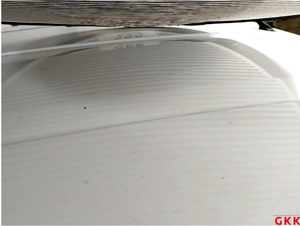
Bild 15 Dach, beschädigt, instand setzen - lackieren
