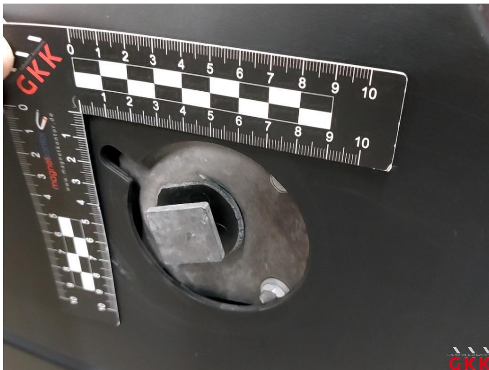
Bild 36 Anschlag / Hecktür links, fehlt, ersetzen
