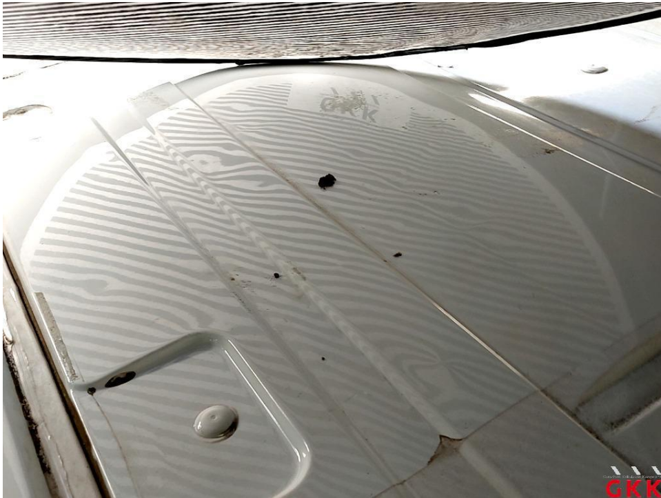
Bild 17 Dach, beschädigt, instand setzen - lackieren
