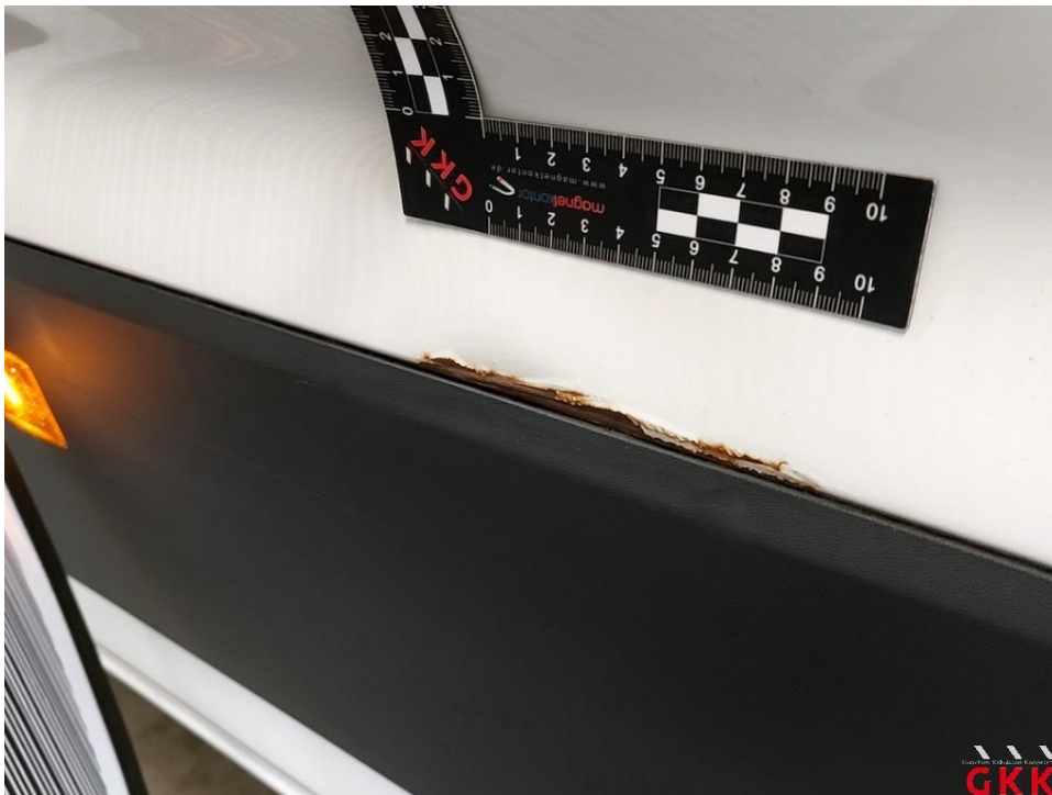
Bild 44 Seitenwand links, beschädigt, instand setzen - lackieren
