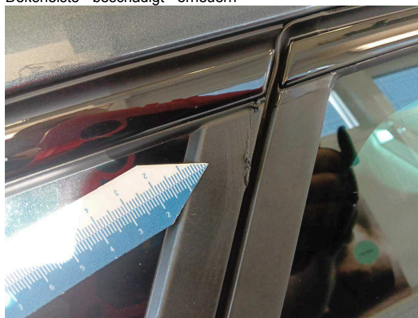
Beschädigung #3: Verkleidungen/Abdeckungen: Zierleiste / Dekorleiste - beschädigt - erneuern
