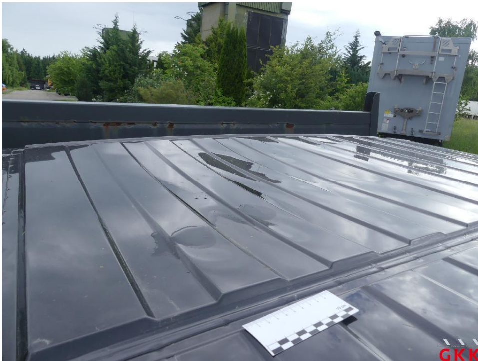
Bild 24 Dach, beschädigt, instand setzen - lackieren
